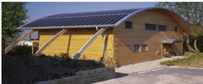
Module souple sur « bac zinc »
