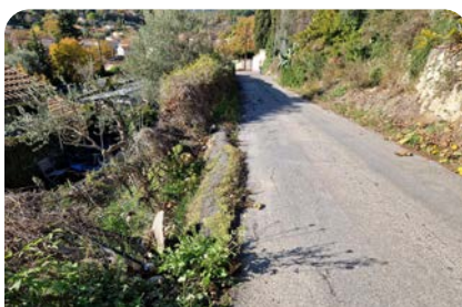
Étude et travaux mur de soutènement chemin du Colombier
