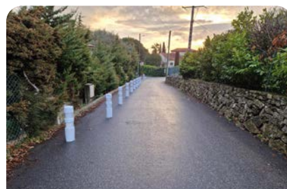
Étude et travaux mur de soutènement chemin des Bourges
